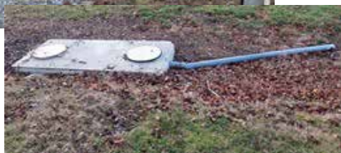
Création du site pour l'installation du bouilleur de cru
